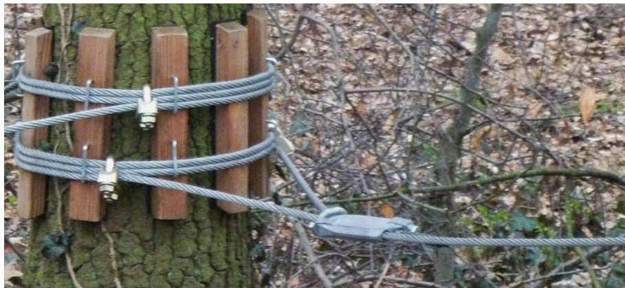
Fot. 3. Mocowanie elementu stałego niskiego parku linowego Photo 3. Element of stationary Low Ropes Course
