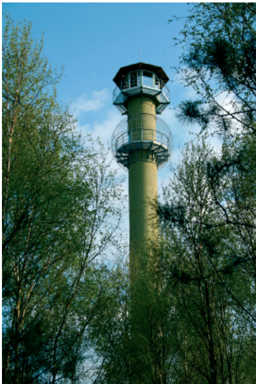
Fot. 3. Nowa dostrzegalnia przeciwpożarowa na Górze Pożarowej koło Dąbrówki Leśnej, z platformą umożliwiającą oglądanie widoków przez turystów (fot. P. Anders)
