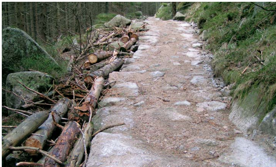
Fot. 2. Wykonany zabieg zabudowy przeciwoerozyjnej rynny erozyjnej na szlaku turystycznym (fot. D. Kuś) Photo 2. The process of anti-erosion building on erosion gutter on the tourist trail
