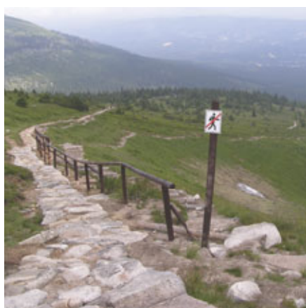
Fot. 3. Żółty szlak po remoncie – kanalizowanie ruchu turystycznego i ograniczanie zasięgu szkód (koszt remontu 2 km szlaku 766 tys. zł ) (fot. B. Wieniawska)
