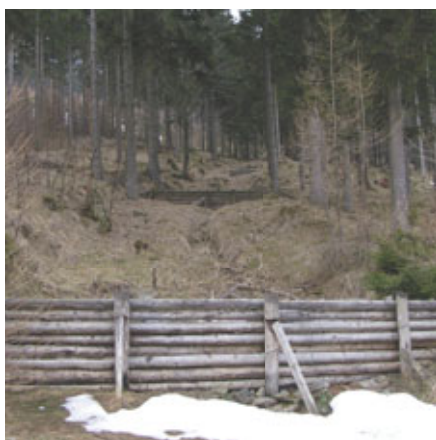
Fot. 9. Zabudowa rynny erozyjnej. Systemy drewnianych tam (fot. D. Kuś)
