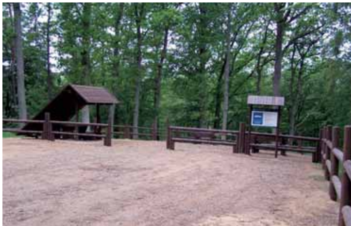
Fot. 10. Miejsce postoju pojazdów w Nadleśnictwie Strzebielino, wybudowane w ramach programu Aktywne Udostępnianie Lasu (fot. Z. Popławski)
