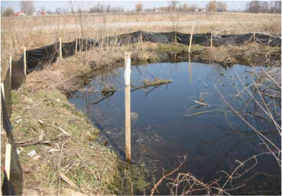
Fot. 4. Wygradzenia na placu budowy Photo 4. Building sites fencing
