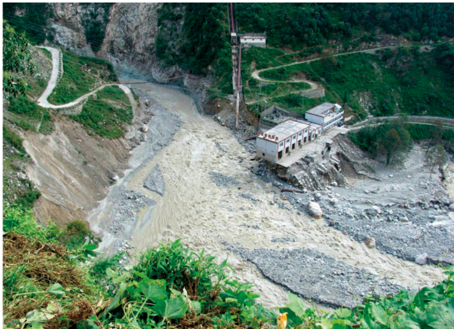
Fot. 1. Elektrownia wodna położona nieopodal Moxi zniszczona podczas sypływu gruzowego w 2005 roku Photo 1. Hydroelectric power station located near the Moxi destroyed during the debris flow in 2005
