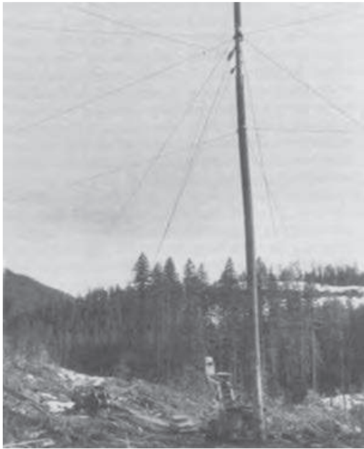
Fot. 1. Drzewo podporowe z zainstalowanym olinowaniem do zrywki typu high-lead (Pearce, Stenzel 1972)
