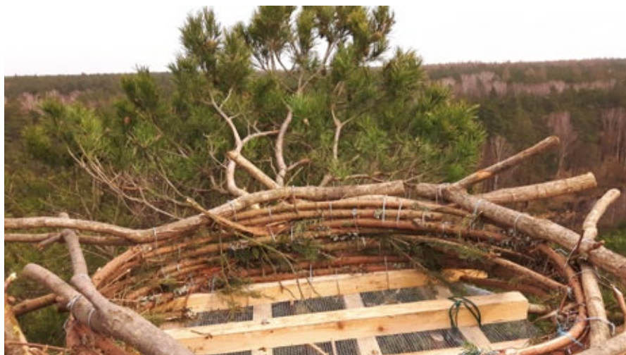
Fot. 3. Wzorcowca platforma nadrzewna dla rybołowa wykonana z modrzewiowych krawędziaków, nierdzewnej siatki i zdrutowanych świerkowych gałęzi (fot. M. Urban)
