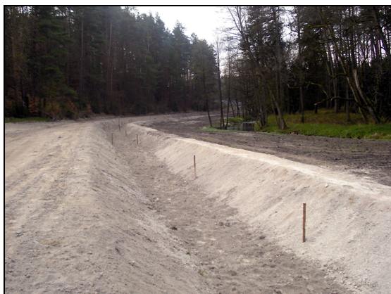
Fot. 1. Dolina rzeki Kulawy. Fragment głównego rowu doprowadzającego w trakcie odbudowy (fot. Wiesława Orzłowska)
