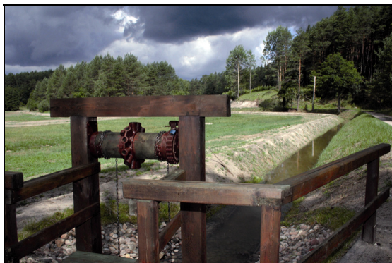
Fot. 4. Dolina rzeki Kulawy. Wyremontowany przepust z zastawką (fot. Wiesława Orzłowska) Photo 4. Valley of Kulawa River. Reconstructed culvert with penstock
