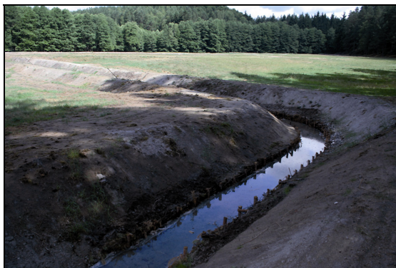
Fot. 2. Dolina rzeki Kulawy. Napelnianie wodą systemu rowów (fot. Wiesława Orzłowska) Photo 2. Valley of Kulawa River. Ditch system being filled with water
