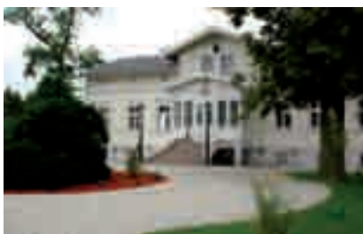
Fot. 2. Budynek widok od frontu (fot. J. Wojdecki)
