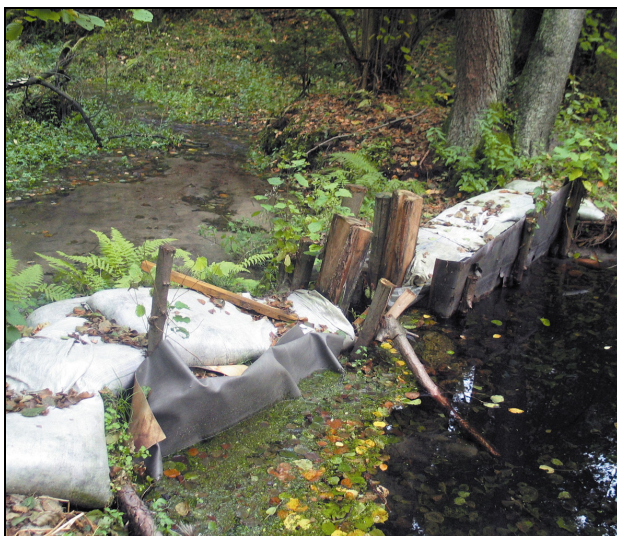
Fot. 6. Zabudowa powodująca zmianę warunków hydrologicznych w postulowanym rezerwacie Źródła Ceteńki (fot. M. Kiedrzyński)
